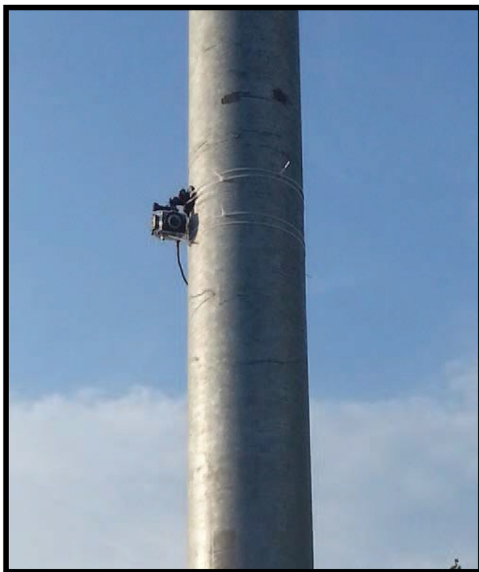
Рисунок 4 – Монтаж видеокамеры на столб линии электроосвещения
